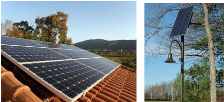
Φωτοβολταϊκά σε στέγη και σε στύλο
