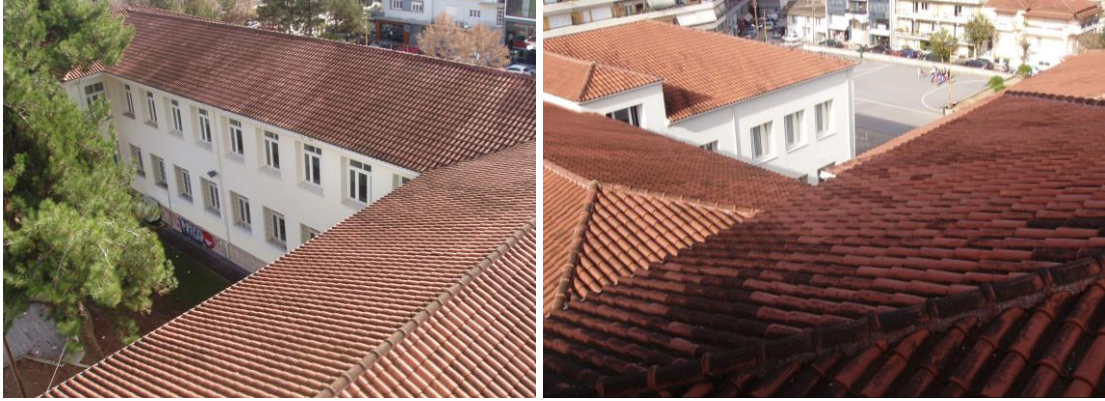
Όψεις της στέγης του σχολείου
