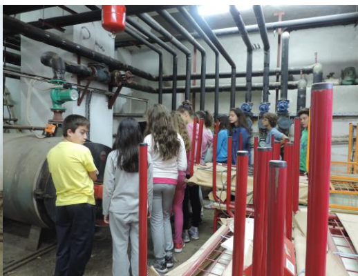
Ομάδα μαθητών στο λεβητοστάσιο
